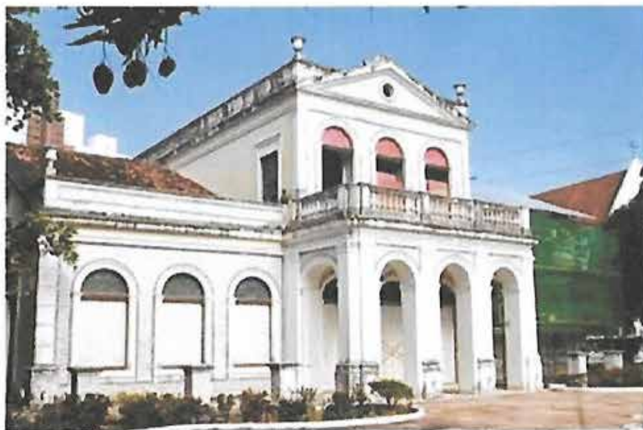
CASARÃO Reforma da APL está orçada em R$ 2 milhões
