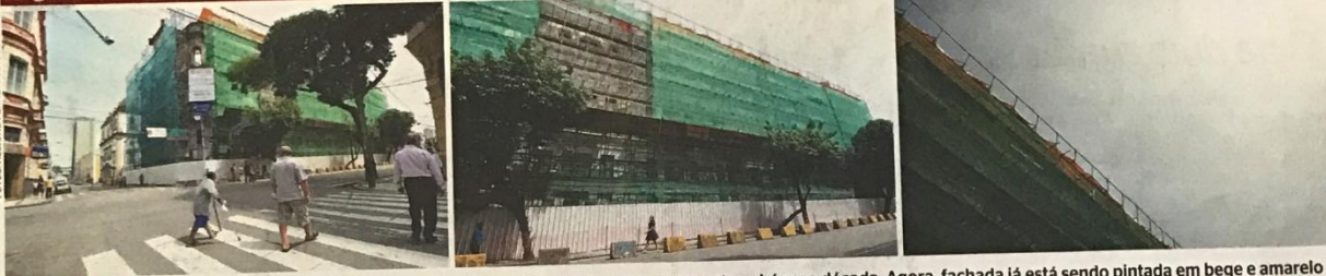
século 19 // Construído para abrigar moradores de classe média alta, imóvel está em obras há uma década. Agora, fachada já está sendo pintada em bege e amarelo
