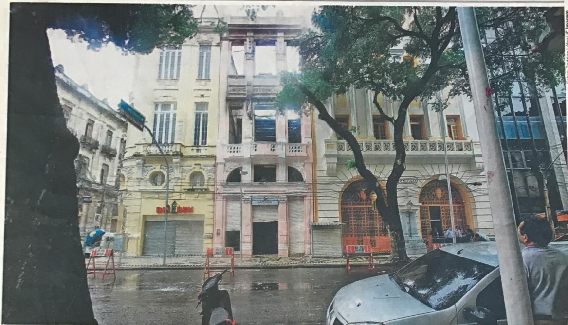
PROTEÇÃO Área foi isolada após incêndio que atingiu prédio de número 142 na Rua Marquês de Olinda, na quarta-feira à noite. Na edificação tombada funcionavam um restaurante e um pub
