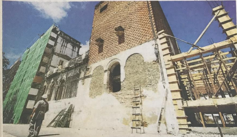
CONTRIBUIÇÃO Campanha ajudará na conclusão das obras de restauração do Hospital Pedro II
